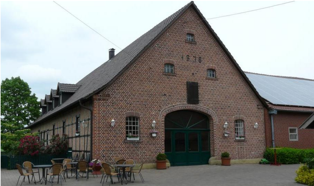
Ansicht Deele mit Solarthermie (auf dem Anbau rechts )
