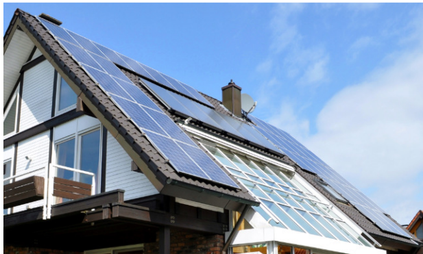
8 kWp Dach-PV-Anlage
