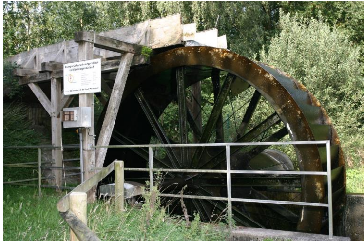
Abb.: Wasserrad Kläranlage Warendorf
