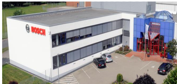
Produktionsstätte Bosch Solarthermie Wettringen
