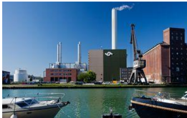
Ansicht: GuD-Kraftwerk am Hafen
